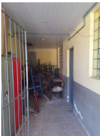
Figura 25 – Acesso a Sala de Leitura E.M.E.F. Comunitária Parque Fragata
