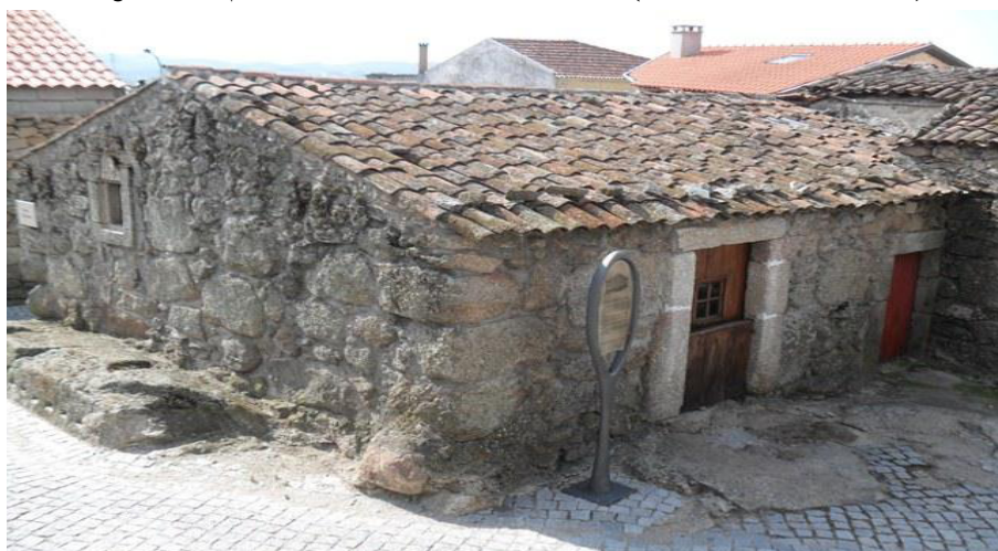
Figura 1 – Aspeto atual da casa da Roda de Caria (distrito de Castelo Branco)
