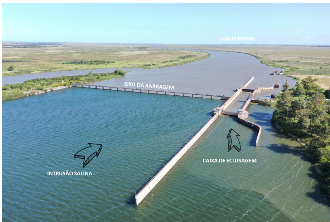
Figura 7- Barragem Eclusa do Canal São Gonçalo.
