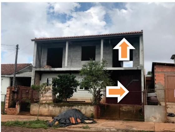
Figura 5.20: Ampliação realizada em moradia do Conjunto Amanhecer II, criação de 2º pavimento e ampliação lateral. Fonte: Autora, 2019.
