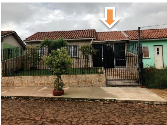
Figura 5.24: Ampliação lateral realizada pelo morador do Conjunto Amanhecer II. Fonte: Autora, 2019.
