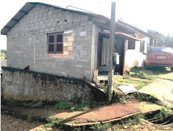
Figura 5.7: Desnível do lote com relação à calçada, revelando a altura do muro de contenção. Fonte: Autora, 2019.
