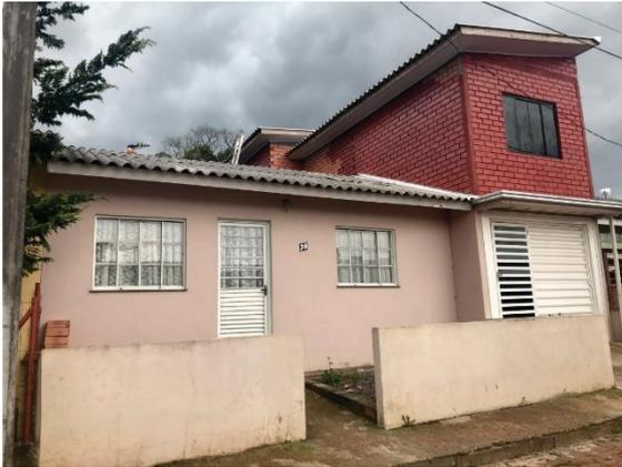
Figura 6.15: Apropriação da moradia do Conjunto Carlotto com a adição de outro volume e colocação de revestimento.
