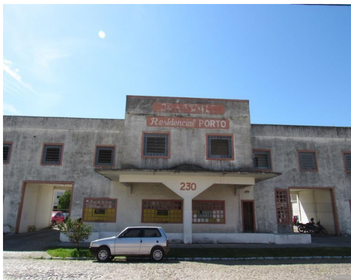
Figura 9: Fachada principal do condomínio (situação atual).
