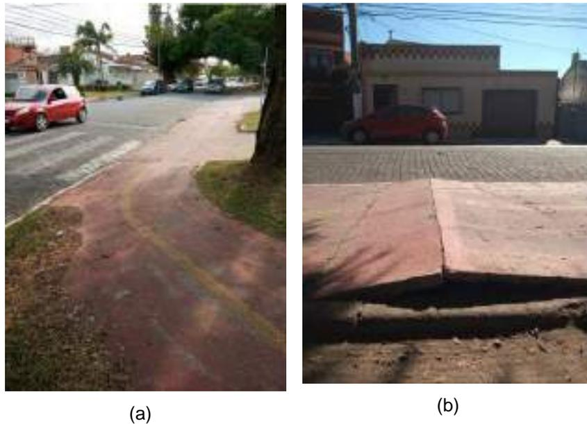
Figura 43: (a) vegetação invadindo a pista; (b) ruptura e levantamento de placa de concreto da pista. Fonte: equipe do autor, 2021.
