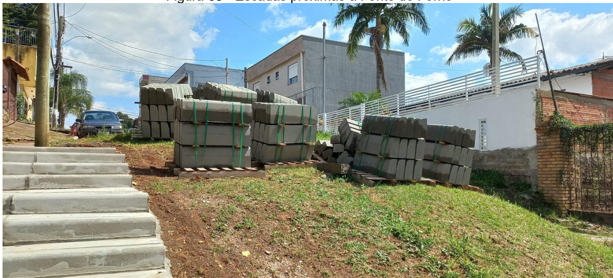
Figura 68 - Escadas próximas à Fonte do Forno
