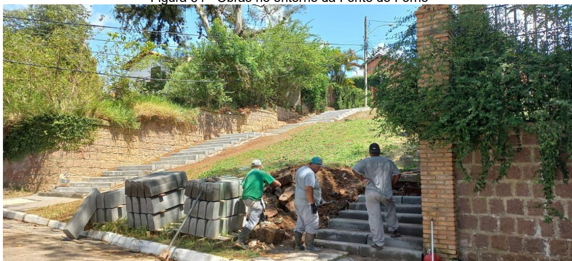
Figura 34 - Obras no entorno da Fonte do Forno
