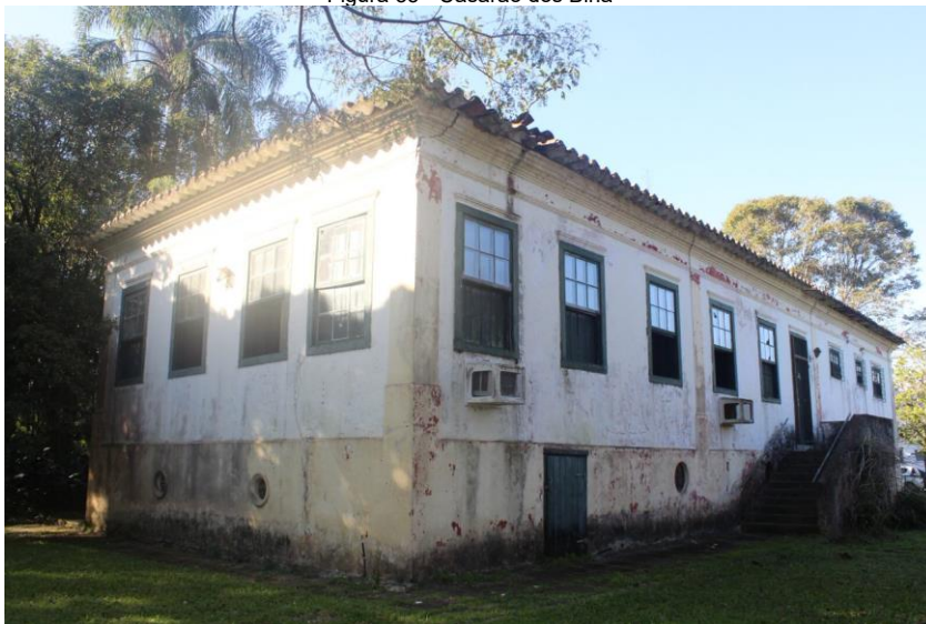
Figura 35 - Casarão dos Bina
