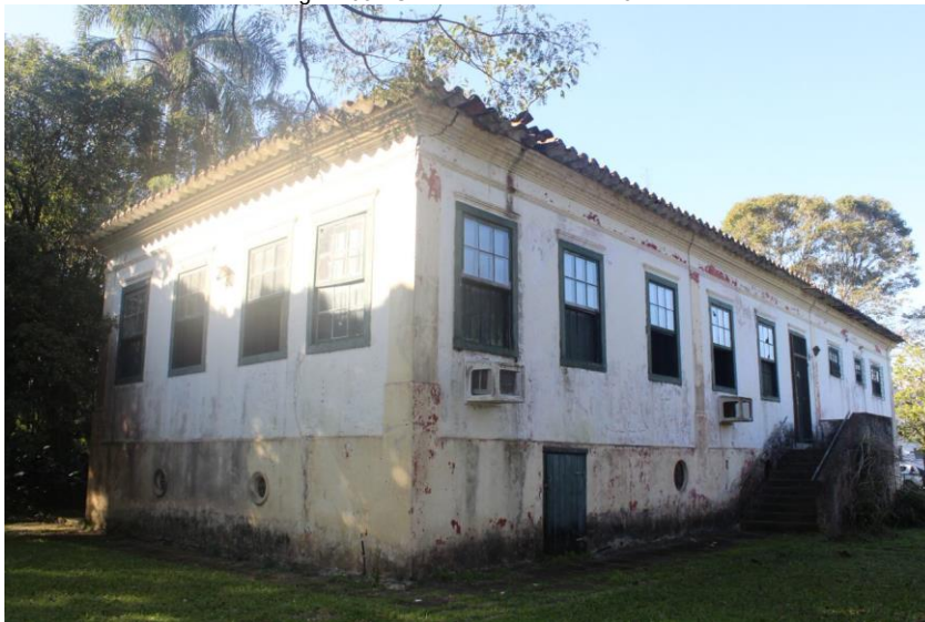
Figura 66 - Casarão dos Bina em 2021
