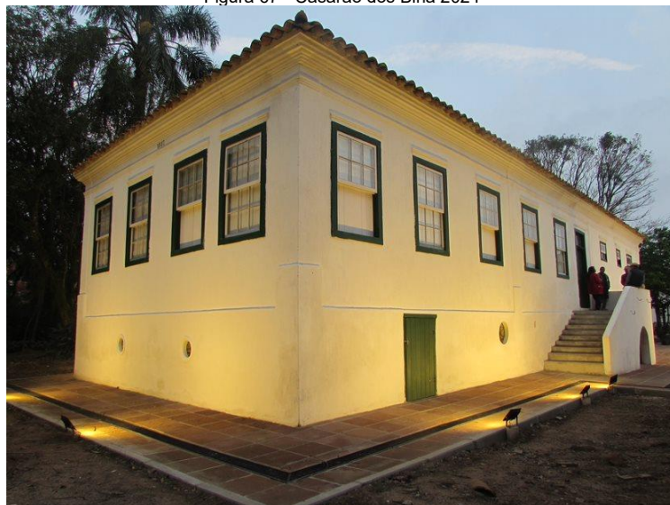
Figura 67 - Casarão dos Bina 2024
