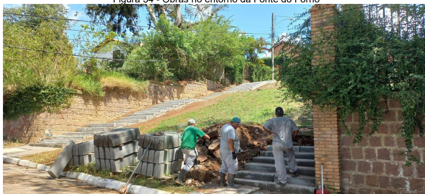
Figura 34 - Obras no entorno da Fonte do Forno
