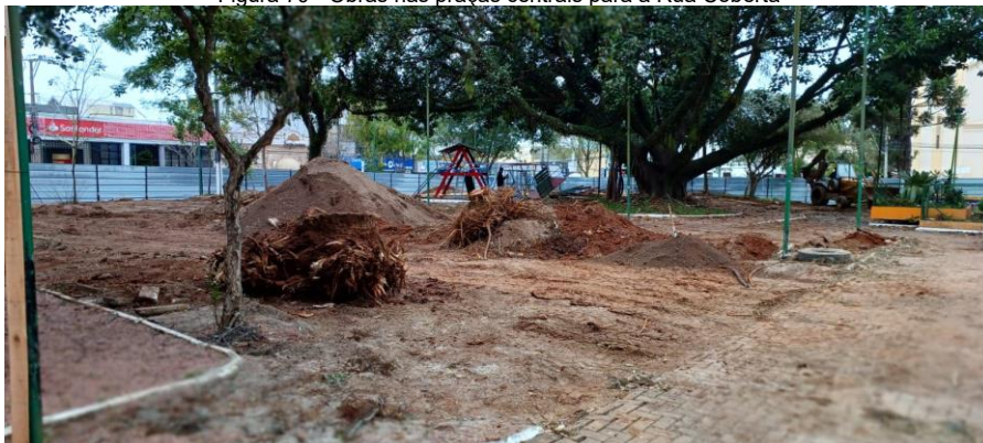
Figura 70 - Obras nas praças centrais para a Rua Coberta
