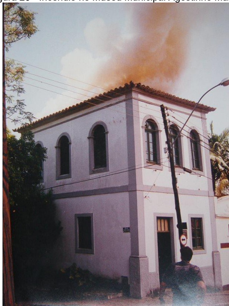
Figura 20 - Incêndio no Museu Municipal Agostinho Martha
