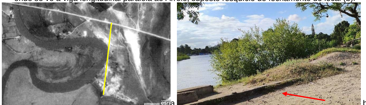
Figura 53 – Imagem aérea de 1975 com demarcação da via com fechamento, em amarelo (a) fotografia onde se vê a viga longitudinal paralela ao Arroio, suposto resquício de fechamento do local (b).
