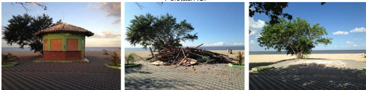
Figura 49 – Fotografias de antes, durante e depois da demolição de construções na orla do Laranjal, Pelotas/RS.
