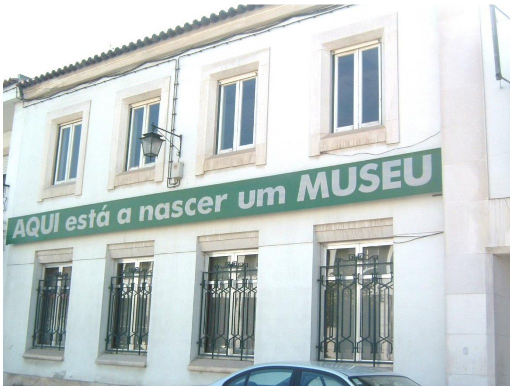
Figura 14: O prédio antes de ser reformado para receber o MCCB
