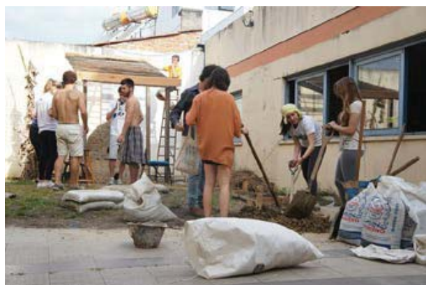
Figura 3: Fotografia do momento de intervenção: a construção do banco e da cobertura verde do forno.
