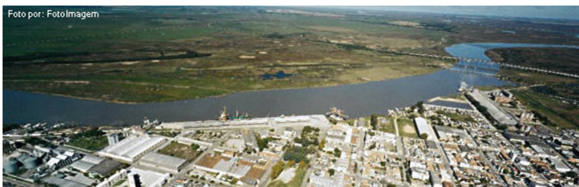
Figura 2 – Vista aérea atual do porto de pelotas.
