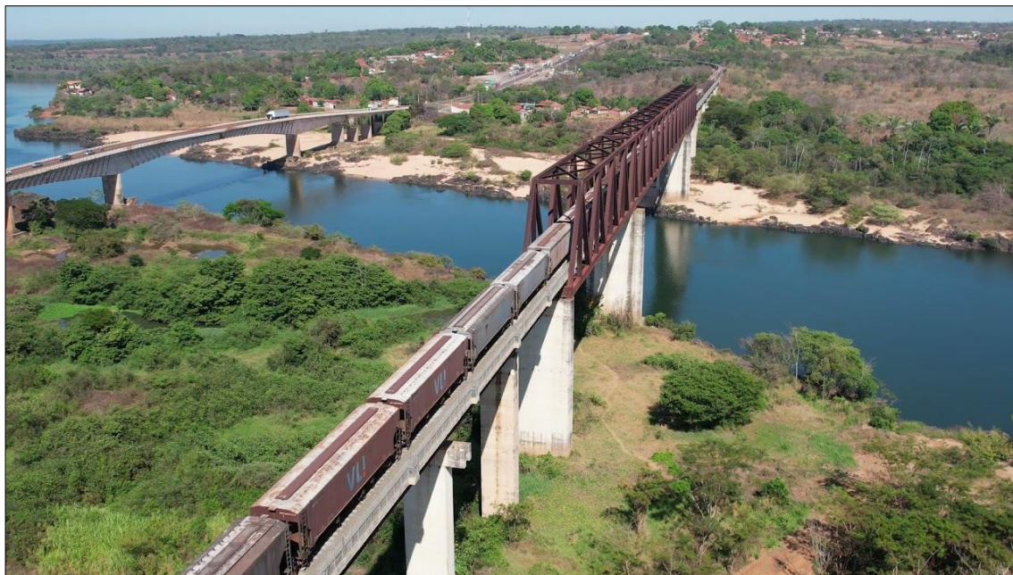
Fotografia 6 – Ponte Juscelino Kubistchek e Ponte da Ferrovia Norte-Sul
