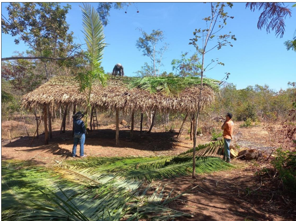
Fotografia 5 – A construção do novo barraco
