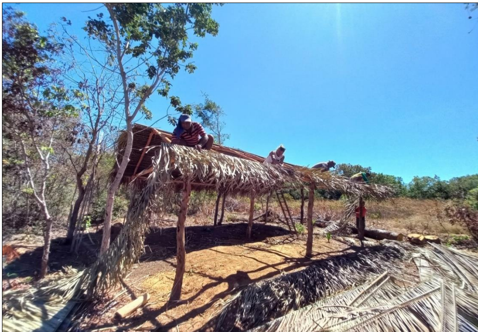
Fotografia 4 – A cobertura do novo barracão
