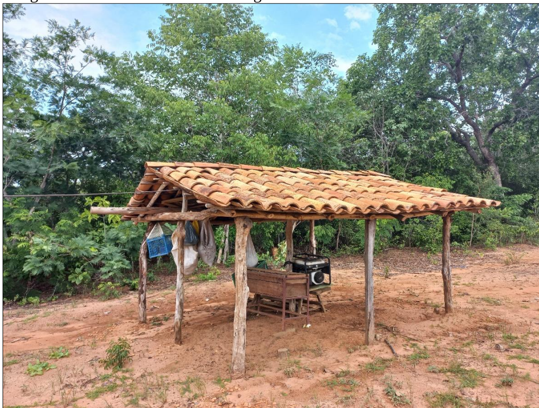
Fotografia 21 – Casa do motor de energia
