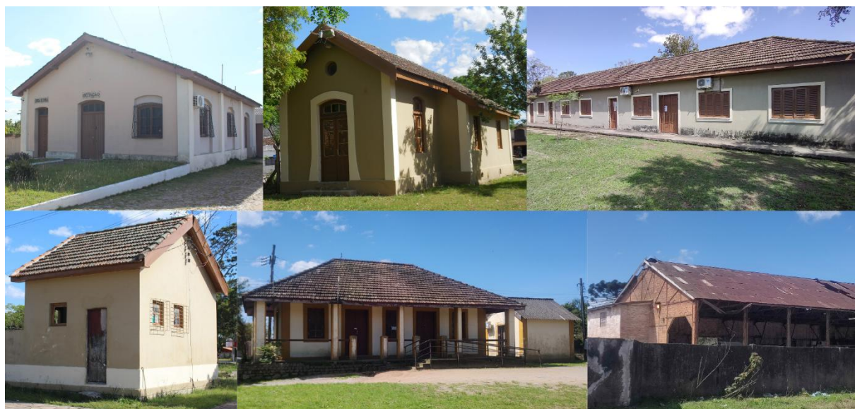
Figura 43 – Estruturas ferroviárias ocupadas pela administração municipal
