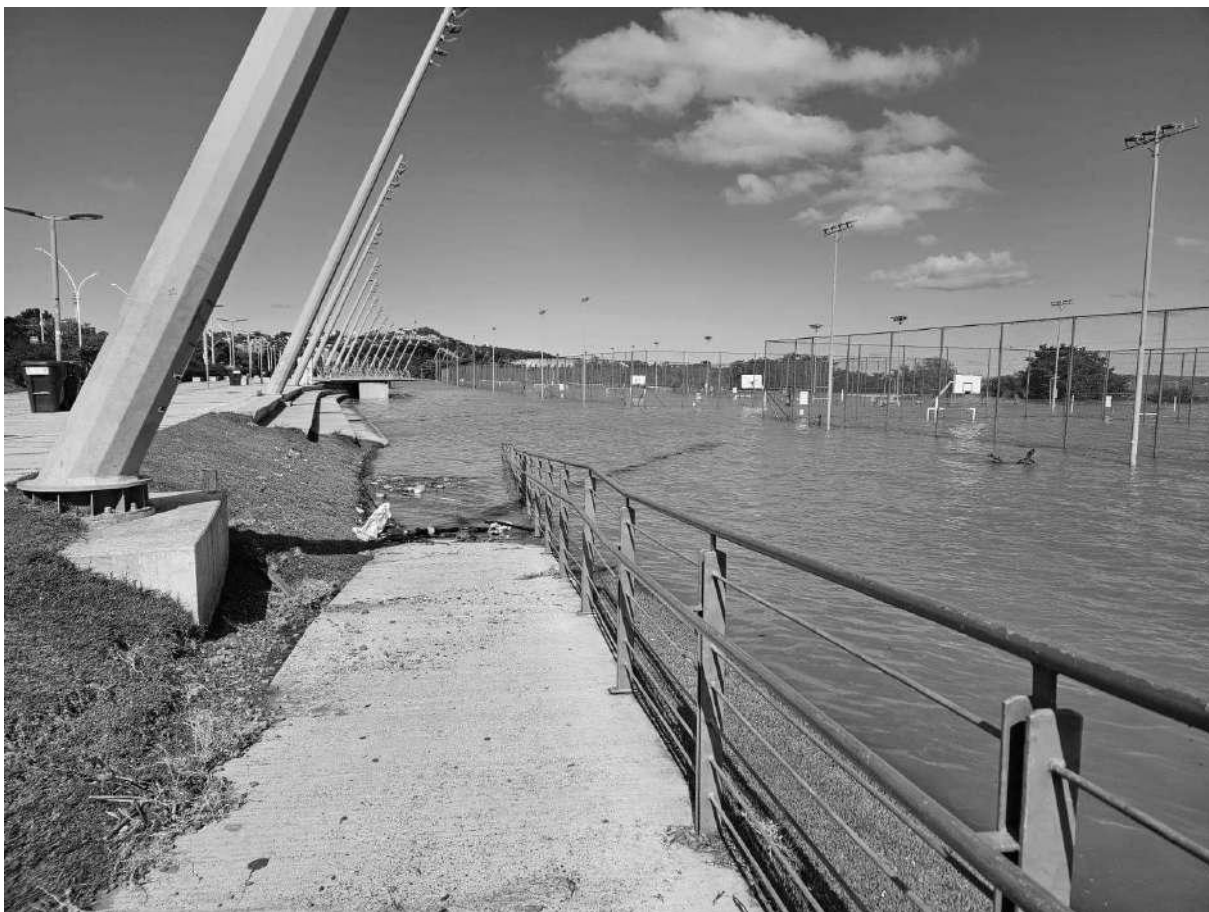
Figura 6 – Inundação na orla – trecho 3
