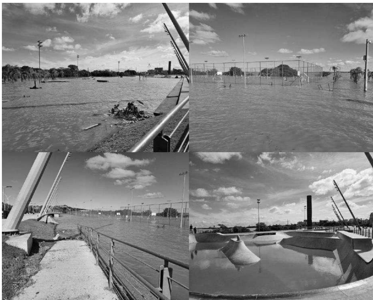
Figura 61 – Inundação trecho 3 -Maio2024
