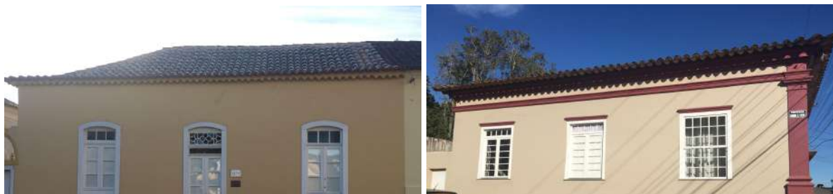
Figura 32- Cobertura com cunhal.
