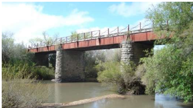
Figura 75 - Ponte do Império sobre o Rio Piratini.
