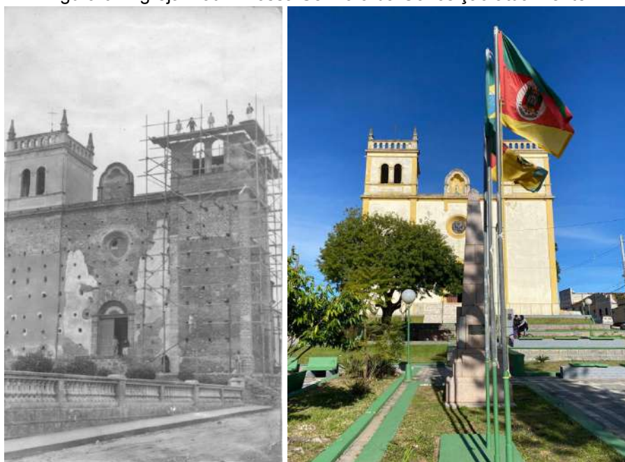
Figura 06- Igreja Matriz Nossa Senhora da Conceição durante a construção da segunda torre (s.d.). Figura 07- Igreja Matriz Nossa Senhora da Conceição atualmente.
