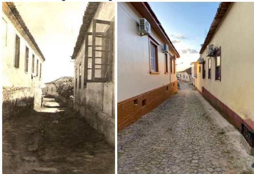
Figura 13- Antiga atual do Beco da Santa.
