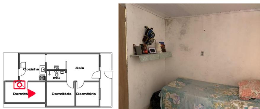
Figura 4.21: Dormitório com parede apresentando sinais de mofo. Fonte: Autor, 2022.
