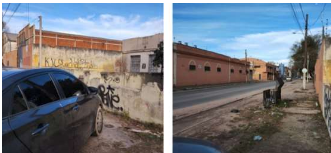
Figura 52 – Casas com muro baixo na rua João Pessoa e na Conde de Porto Alegre. Fonte: ACERVO DA AUTORA, 2023.
