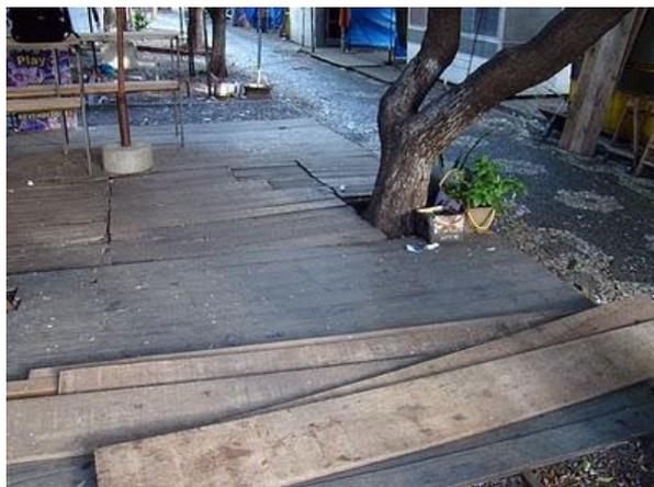
Figura 41 - Fotografia dos tapumes de madeira que cobriram o revestimento original da calçada (*Petit pavet*).
