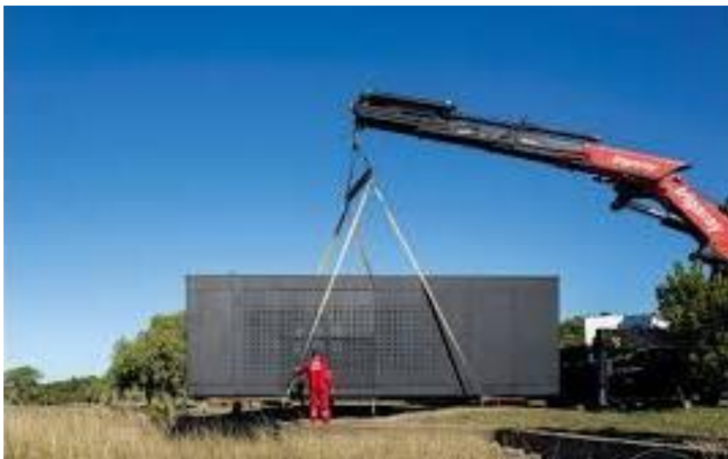
Figura 10 - Montagem N2, estruturar canteiro para 'receber' componentes ou iniciar obra
