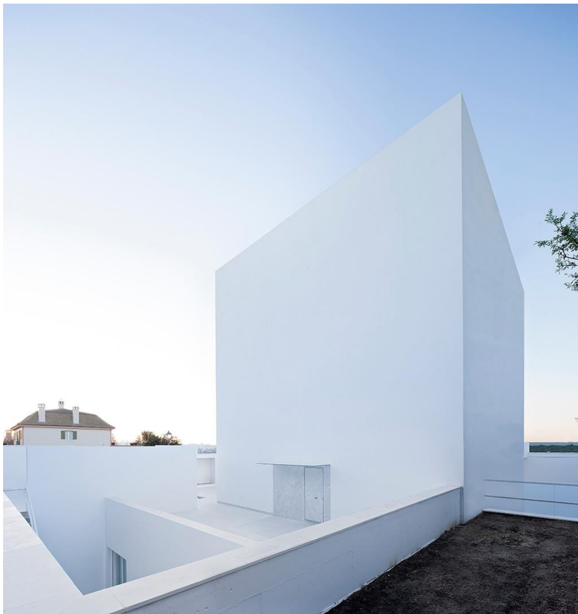
Figura 40 - CASA CALA - Madrid 2015. Vértice Noroeste do terreno com vista a fachada Norte onde está a entrada principal da casa que dá para o pátio seco e empena Oeste. - Fonte: Site oficial: (ACB_Casa-Raumplan_IMAGEN-02.JPG)
