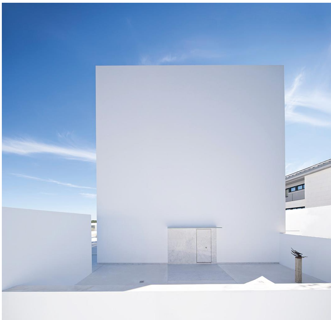
Figura 35 - Porta de acesso à CASA CALA, Fachada Norte. - Fonte: Site oficial: ACB_Casa-Raumplan_IMAGEN-01)
