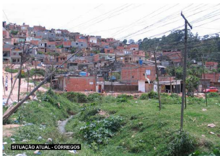
Figura 74: Córregos existentes – antes da implantação do projeto, mas conforme projeto estes foram canalizados.
