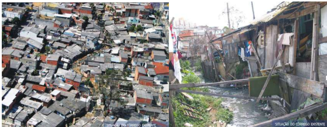
Figura 94: Situação do córrego existente antes da canalização.
