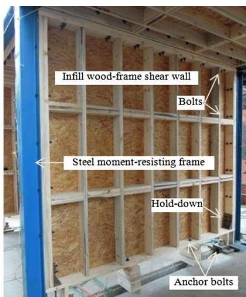
Figura 3- Aplicação típica de um painel OSB como elemento de vedação em uma parede executada em *wood frame*.
