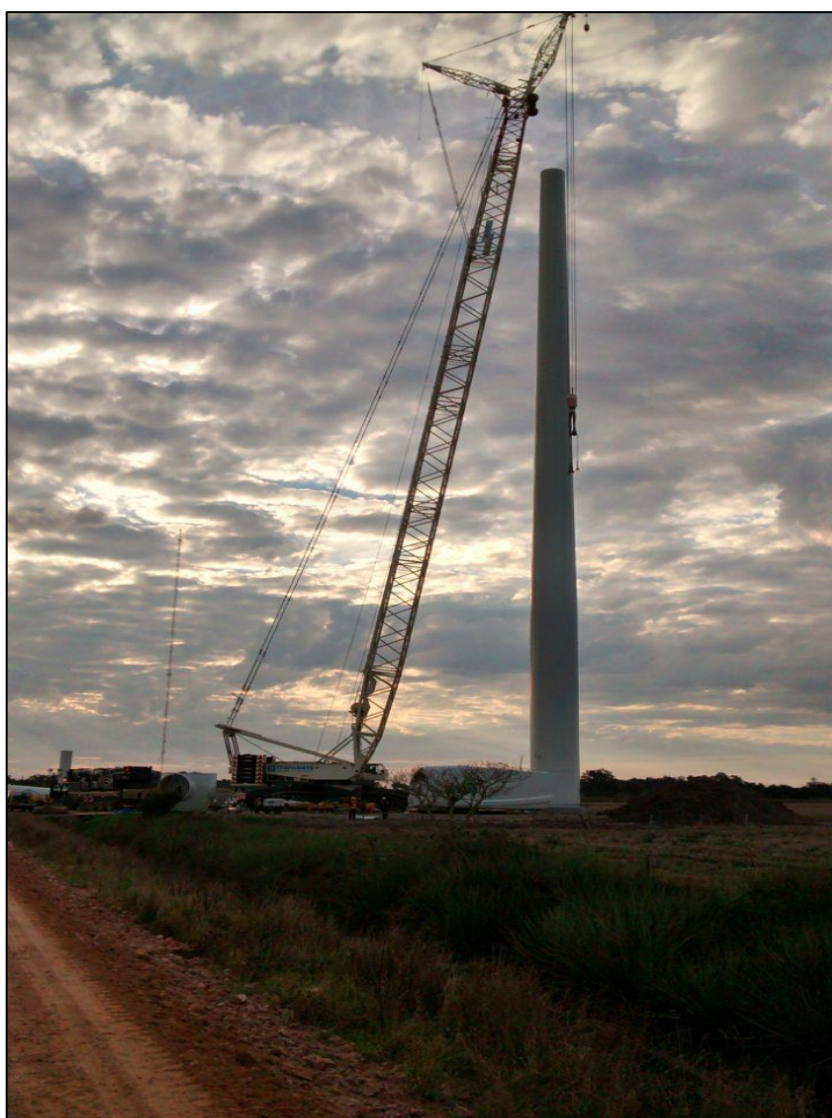
Figura 18 - Instalação do Complexo Eólico Campos Neutrais Fonte: Acervo da Renobrax.
