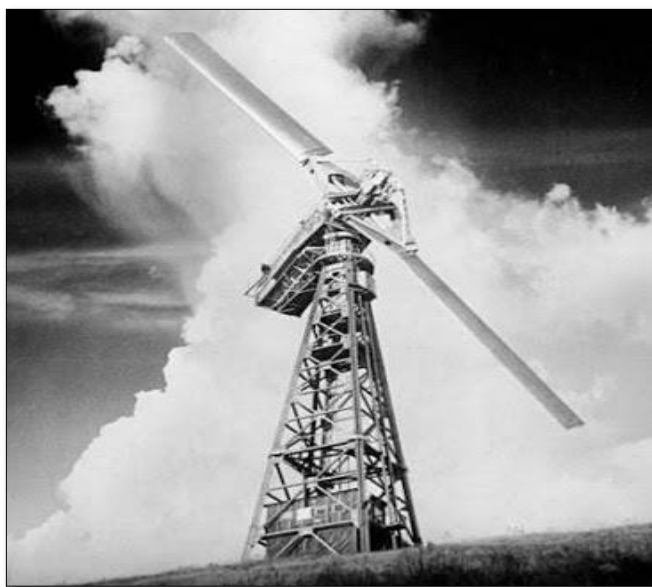
Figura 14 - Aerogerador Smith-Putnam (1941) primeira turbina de grande porte desenvolvida. Fonte: Desconhecida (Data provável 1941)
