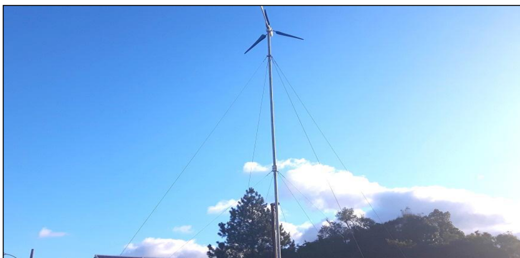
Figura 4 - Outra vista da unidade eólica - Estação Experimental Cascata (EEC) Fonte: Acervo da autora (2016).
