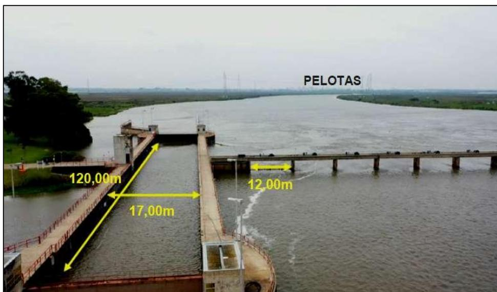
Figura 07 – Detalhe da caixa de eclusagem da barragem do São Gonçalo.
