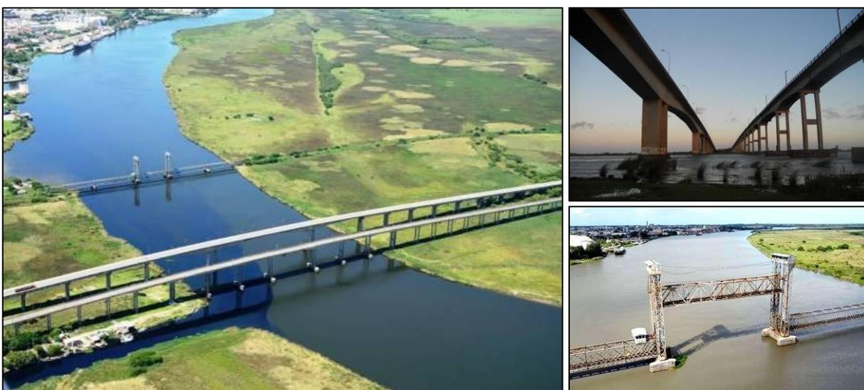
Figura 08 – a) Vista aérea das três pontes sobre o Canal São Gonçalo; b) Vista das pontes rodoviárias, a partir da margem do Canal São Gonçalo; c) Vista da ponte ferroviária com vão móvel. Fonte: CEDPLA (2012).
