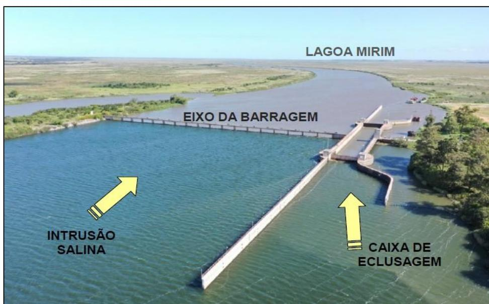
Figura 06 – Vista superior da barragem do Canal São Gonçalo. Fonte: ALM (2023), adaptado pelo autor.
