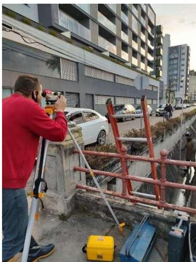
Figura 10 - Instalação das réguas limnimétricas utilizando nível óptico.
