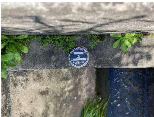
Figura 16 - Referência de nível (RN) instalado na mureta interna do Canaleta da Argolo.
