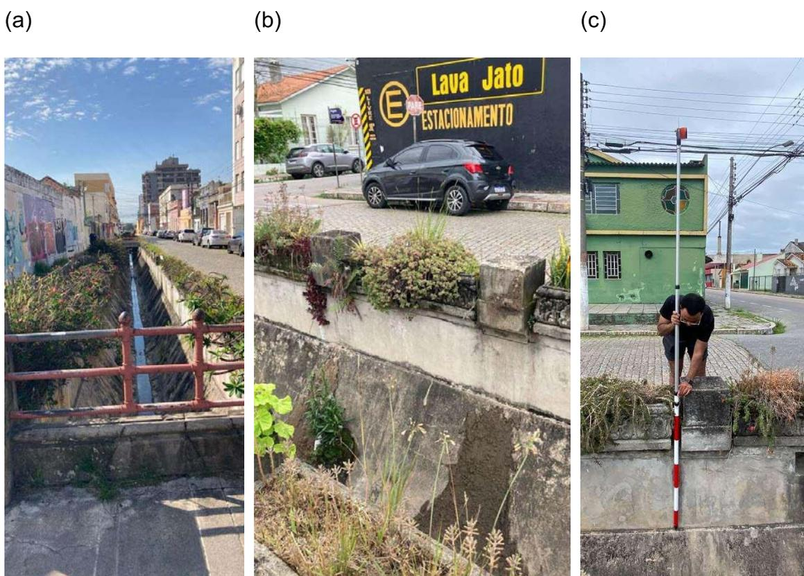
Figura 40 – Mosaico de fotos das floreiras do Canaleta da Argolo que possuem vegetação que impedem o acesso ao seu interior (a) esquina da rua Andrade Neves (b) esquina da rua Gonçalves Chaves (b) durante o levantamento topográfico na esquina da rua Santa Cruz (S3).
