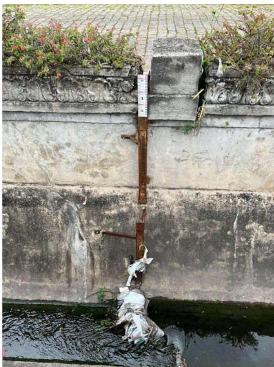
Figura 36 - Registro das réguas furtadas na seção de controle da BHUECA em janeiro de 2024.
