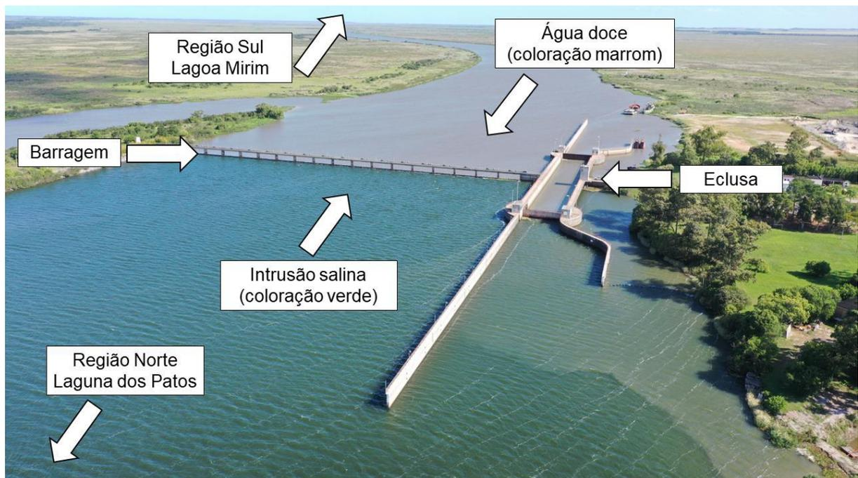
Figura 5 – Barragem do Canal São Gonçalo e sua eclusa de navegação, com destaque para o registro do represamento de água salgada (16/03/2022).
