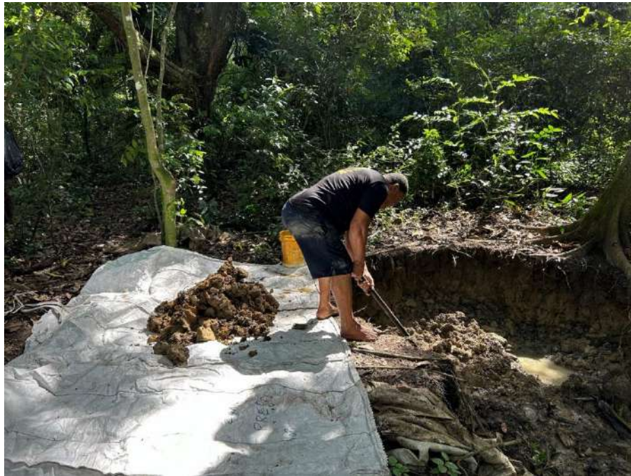
Figura 19: Retirada do barro da cova para colocar na lona.
