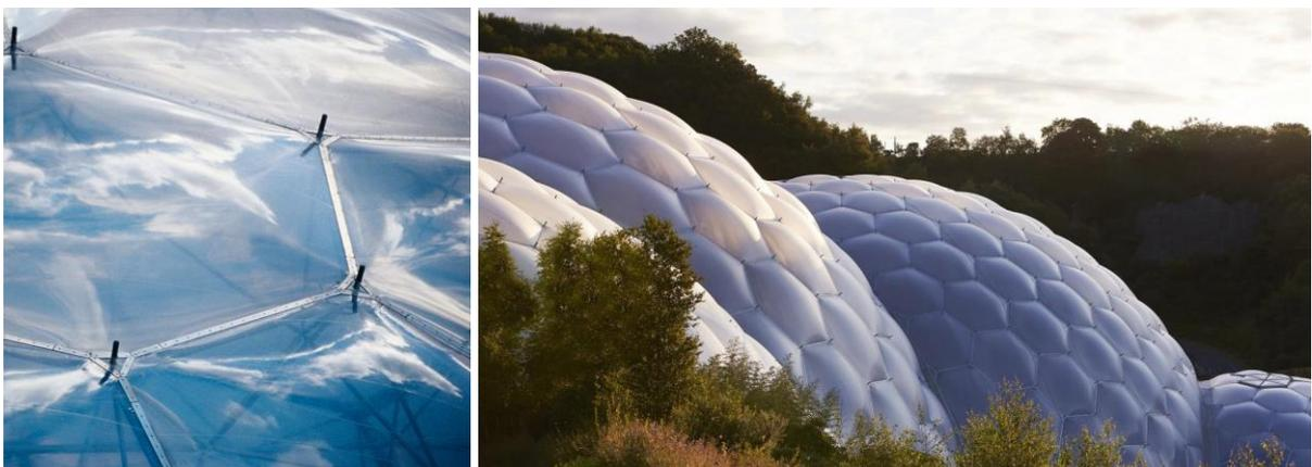
Figura 5.8 Fechamento dos domos com folhas de ETFE. À esquerda, detalhe do revestimento e à direita vista dos domos com destaque para o revestimento inflado.
