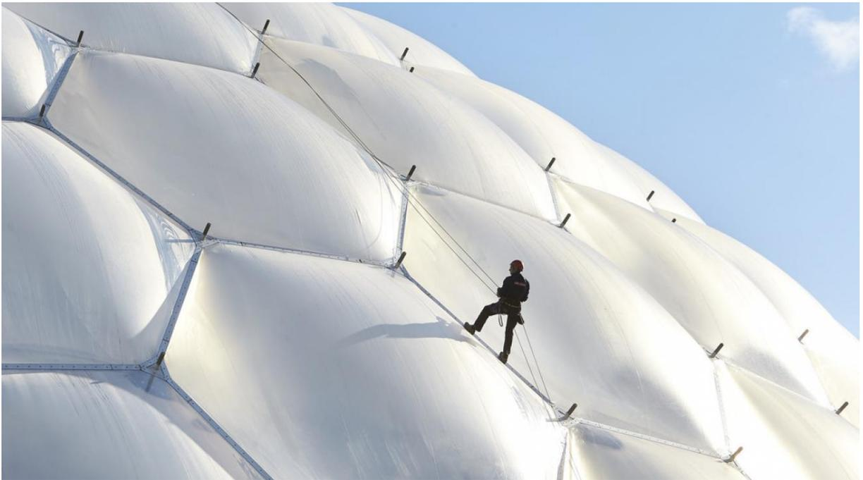
Figura 5.9 Manutenção do fechamento em ETFE.
