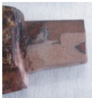
FIGURA 15 - Consolidação com Resina Epóxi - ponteira do raio
