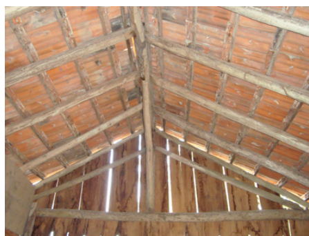
Figura 22: Estrutura do telhado de Caibros com escoras (Fonte: Foto da Autora em 05/07/2009)
