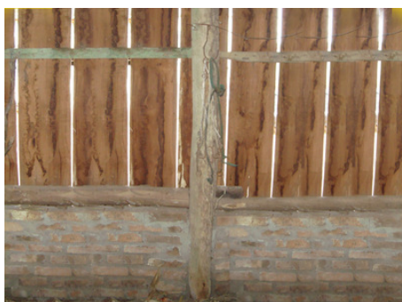
Figura 21: Estruturação das paredes do galpão (Fonte: Foto da Autora em 05/07/2009)
