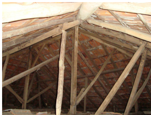
Figura 20: Estrutura do telhado (Fonte: Foto da Autora em 05/07/2009)
