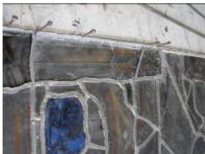
Fig.10 - Remoção das calhas de reparo com alma, nivelamento do painel.
