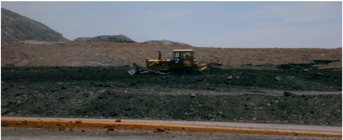
Figura 6: Nivelamento dos cones de rejeitos por trator de esteira
