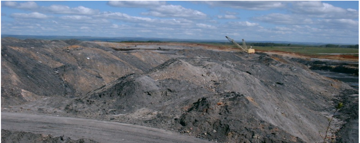
Figura 5: Deposição dos cones de rejeitos pela “dragline”
