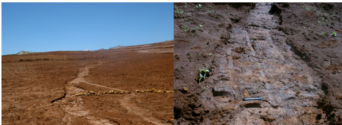
Figura 8: Compactação do solo construído
