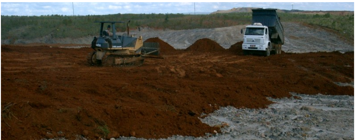
Figura 7: Adição da camada superficial do solo original
