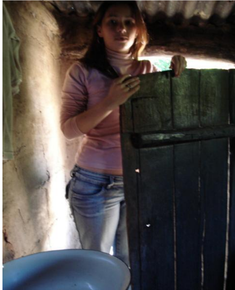
Figura 40: Estrutura das portas
