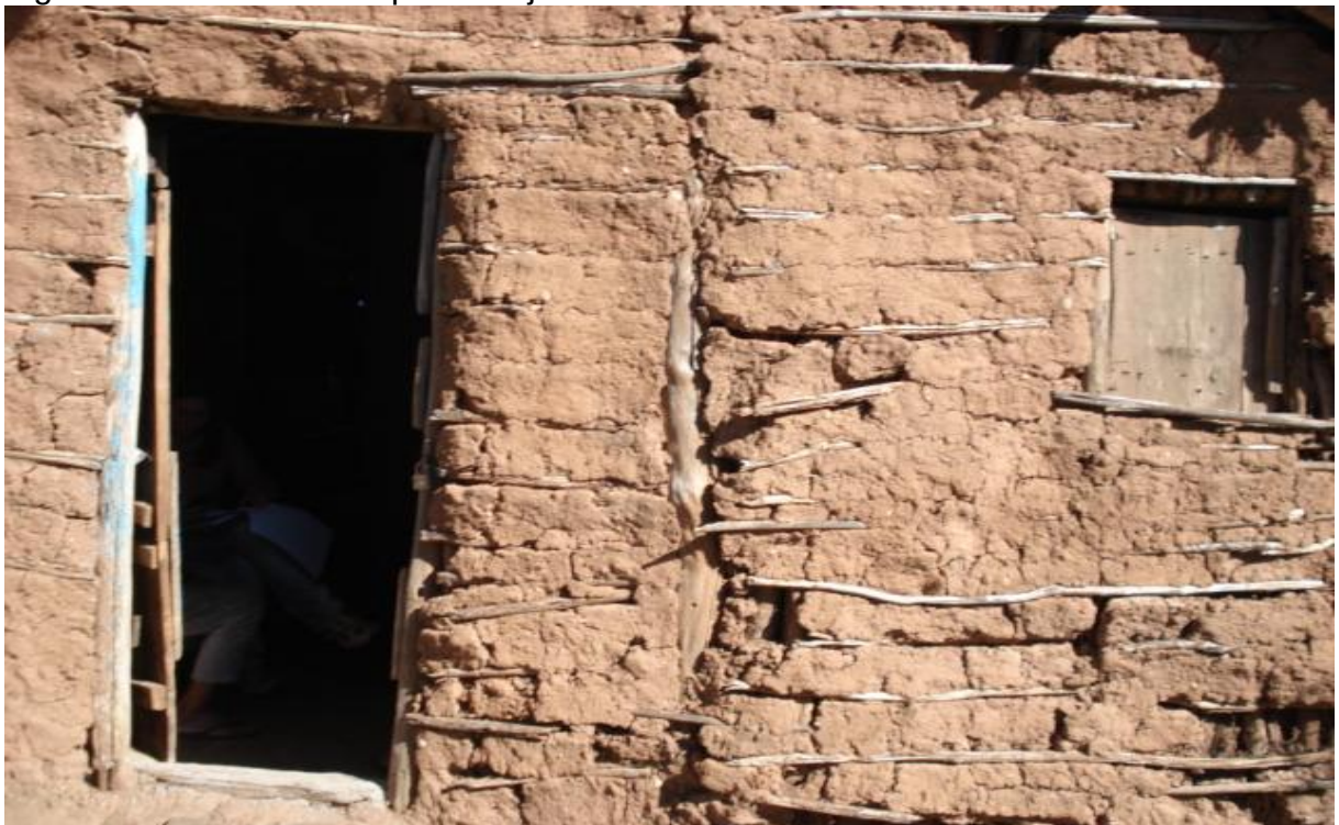
Figura 41: Estrutura das portas e janelas
