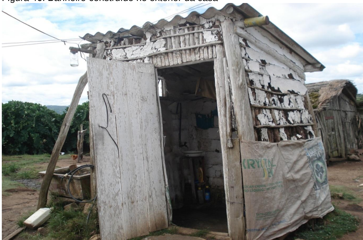
Figura 46: Banheiro construído no exterior da casa
