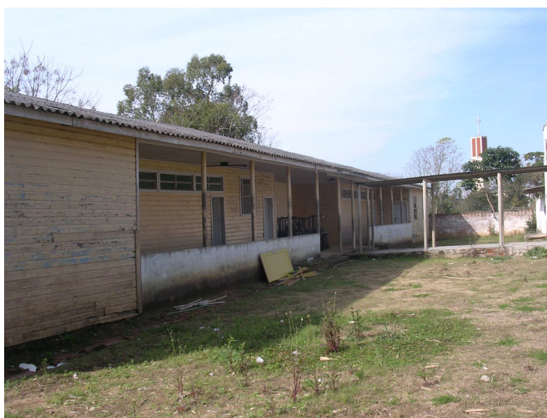
Figura 3: Brizoleta construída em 1962 para funcionar como Ginásio Estadual Getúlio Vargas, atual escola de ensino médio de Pedro Osório. Fonte: Acervo Secretaria Municipal de Educação de Pedro Osório
