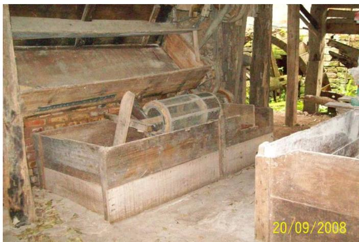
Figura 90: Caixa com peneira. Atafona Henkel. Nova Hartz. RS
