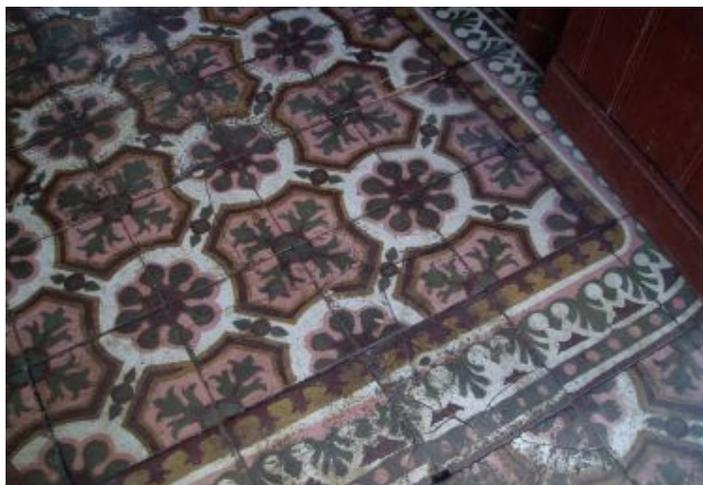
Figura 60: Detalhe do piso de ladrilho hidráulico da cozinha. Família Henkel. Nova Hartz. RS
