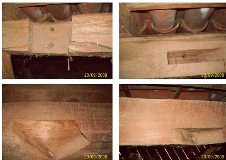
Figura 52: Detalhes dos encaixes da estrutura do telhado anterior à reforma.
