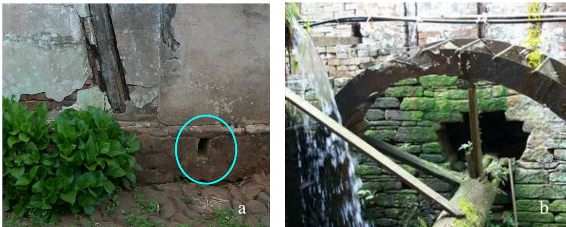
Figura 48: a) Vista do detalhe da gateira. b) Vista do detalhe da fundação de arenito e do encaixe da engrenagem de uma das rodas d'água. Casa da família Henkel. Nova Hartz. RS
