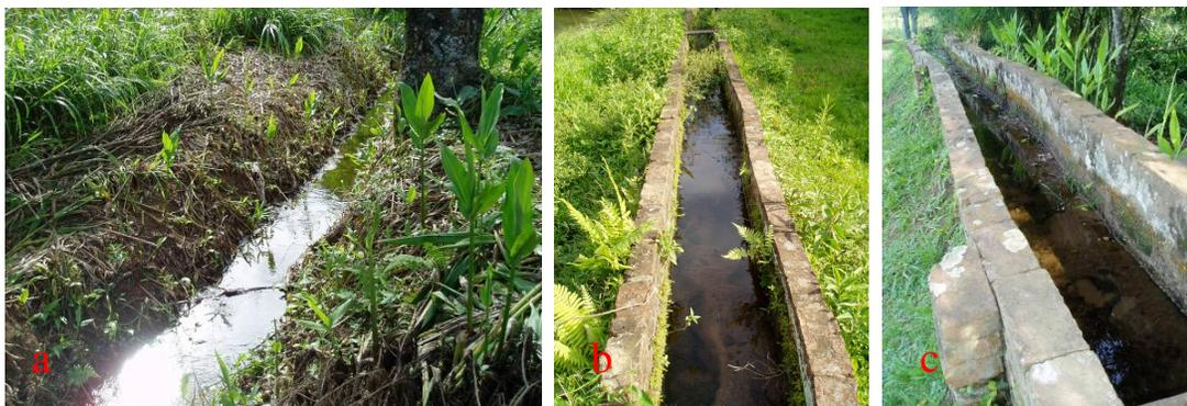
Figura 73: Detalhes do canal a) trecho escavado no solo. b,c) trechos em tijolo. Atafona e Moinho Henkel. Nova Hartz. RS
