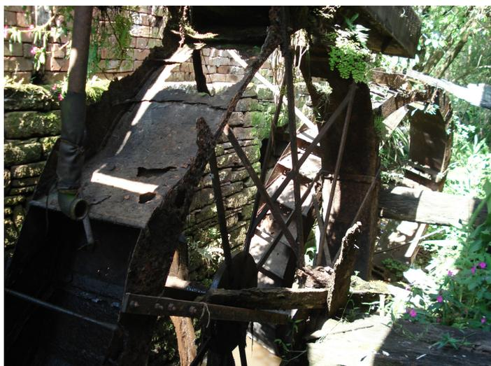
Figura 78: Carcaças das rodas d'água. Atafona e Moinho Henkel. Nova Hartz. RS
