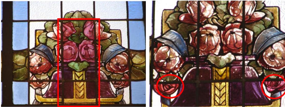
Figura 70: Diferença de coloração de fragmentos, resultado de intervenção recente: comparação da janela esquerda com a janela direita.
