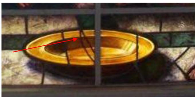
Figura 85: Detalhe da calha de conserto.
