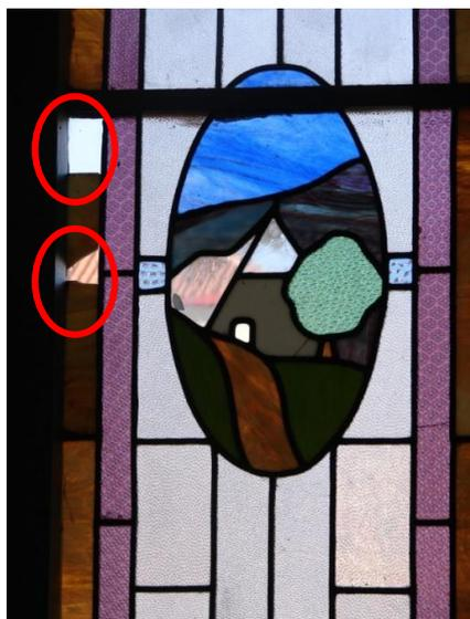
Figura 164: Detalhe de lacuna de material vítreo do painel JNE2.
