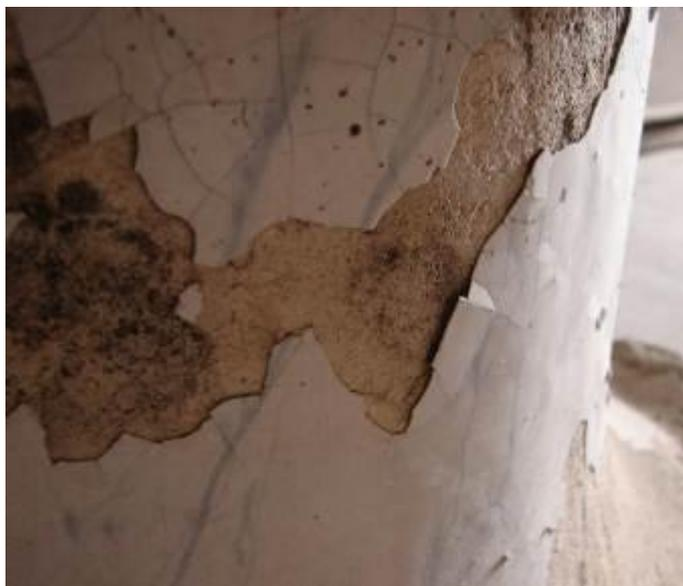
Figura 68 – Descolamento do revestimento no vaso nº 3.
