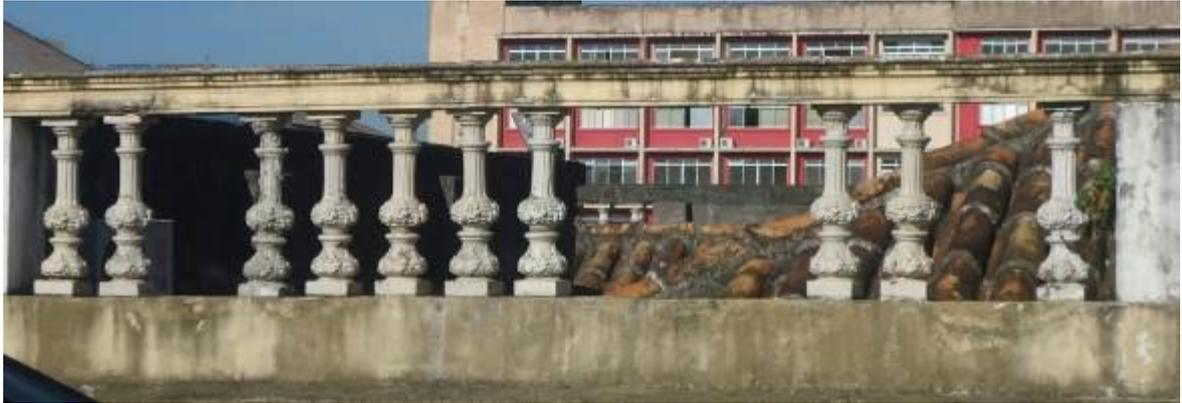
Figura 69 – Detalhe da platibanda do Casarão do Barão de Butuí, estão faltando alguns balaústres.
