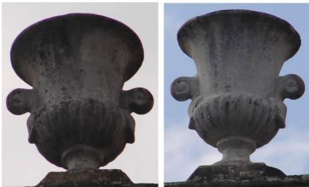
Figura 56 – Vasos de cimento existentes na platibanda do Casarão Barão de Butuí.
